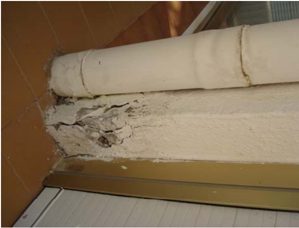
Foto DSC02109 Base muro
