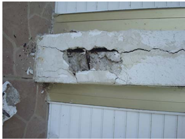
Foto DSC020103 Base muro
